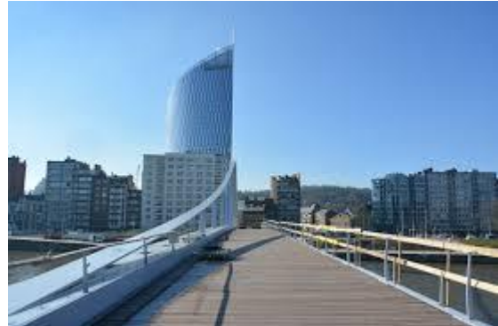
Passerelle reliant le Parc de la Boverie à la Gare des Guillemins
